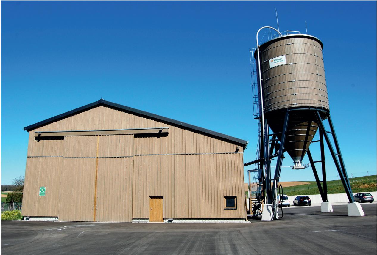
Um ein rasches Füllen von Fahrzeugen zu gewährleisten, wurde eine Salzlagerhalle mit einem Verlaudesilo errichtet.
